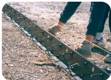
Posizionamento del giunto
