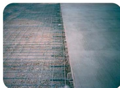
Pavimento finito e pronto per la gettata nella successiva porzione
