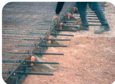
Supporti di contenimento e inserimento dei barrotti
