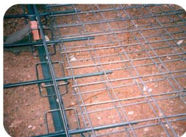
La porzione di pavimento finita pronta per la gettata
