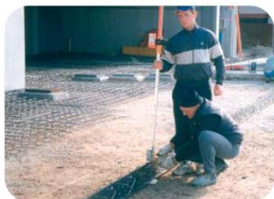
Messa in quota e fissaggio dei moduli
