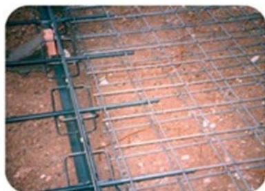
Fertiger Bodenabschnitt, der zum Gießen bereit ist
