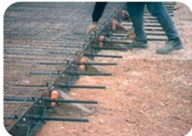
Halterungen und Einsetzen der Bewehrungsstäbe
