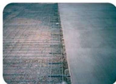
Fertiggestellter Fußboden und Bereitschaft zum Gießen des nächsten Abschnitts
