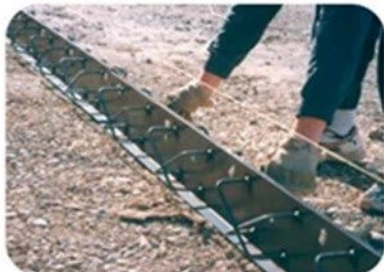
Platzierung des Fugensystems
