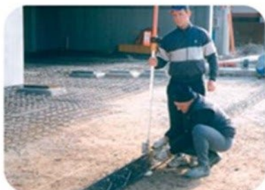
Einbau und Befestigung der Module
