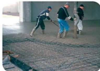
Gießen des Betons wie üblich und Nivellierung mit Richscheit
