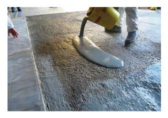
Prima di applicare il betoncino (SFERODUR FP o SFERODUR 2-5) ) o l'intonaco (DECOQUARZ VERTICAL) verificare che lo strato di collante sia uniformemente bagnato. Parti parzialmente asciutte vanno ravvivate con ulteriore strato di APSECOL BETON.
